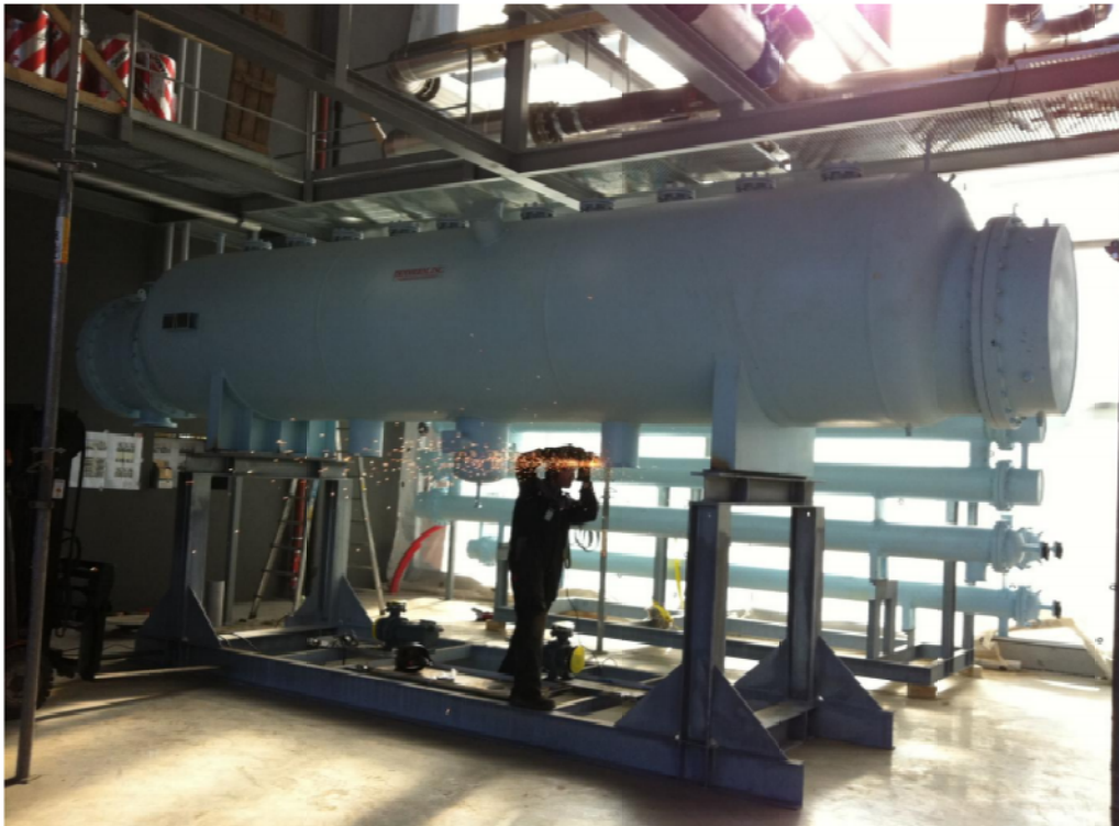
Bilde over: NH3 spray fordampere for 5mW varmepumpe. Nedunder bilde av rørplate.
